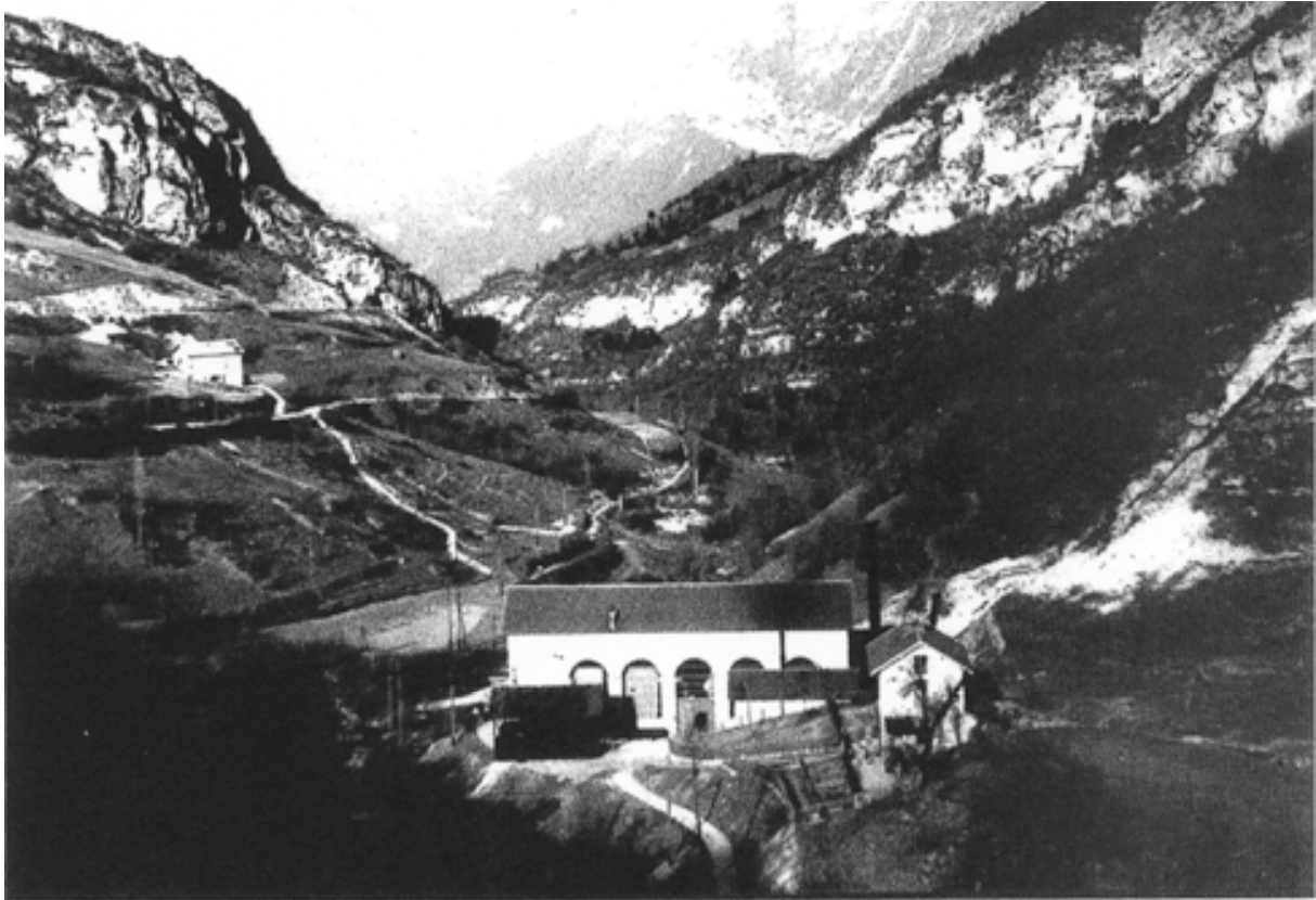
L'ancienne usine hydroélectrique d'Engins
